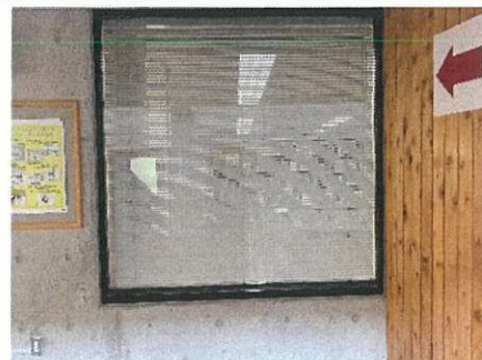
廊下側からの様子。閉ざされた印象。
